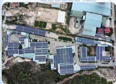
Nhà máy dệt Củ Chi Textile Factory - Cu Chi Công suất/Capacity: 400Kw
