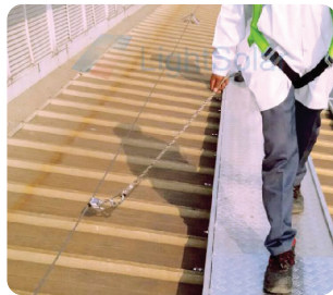
Hệ dây cứu sinh Lifeline system
