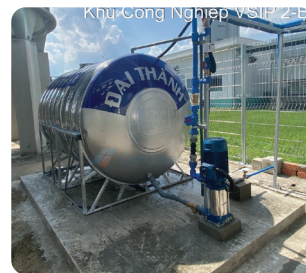
Hệ thống nước rửa pin Panel cleaning water system
