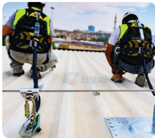
Hệ dây cứu sinh Lifeline system
