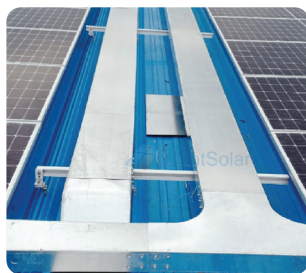
Cầu cáp Cable bridges
