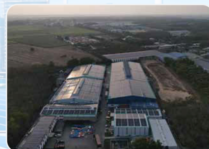
Nhà máy ĐT Nha Trang DT Factory - Nha Trang Công suất/Capacity: 1MWp
