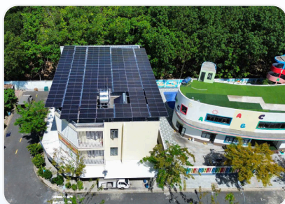
Kho lạnh Bình Phước Binh Phuoc cold storage Công suất/Capacity: 300Kw
