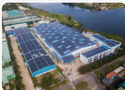
NM Trường Giang - Đà Nẵng Truong Giang Factory - Da Nang Công suất/Capacity: 3MWp
