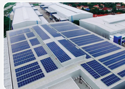
NM Giấy - Bình Dương Paper Factory - Binh Duong Công suất/Capacity: 850kWp
