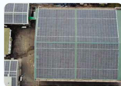
Nhà máy TT Đồng Nai TT Factory - Dong Nai Công suất/Capacity: 400/1Mwp
